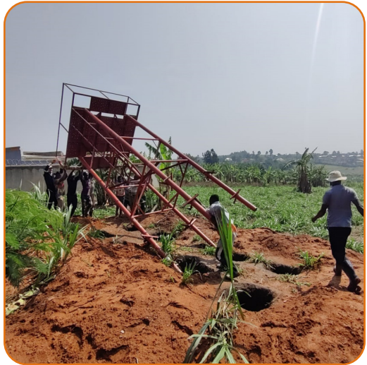
Installatie watertoren in 2m diepe funderingsgaten
