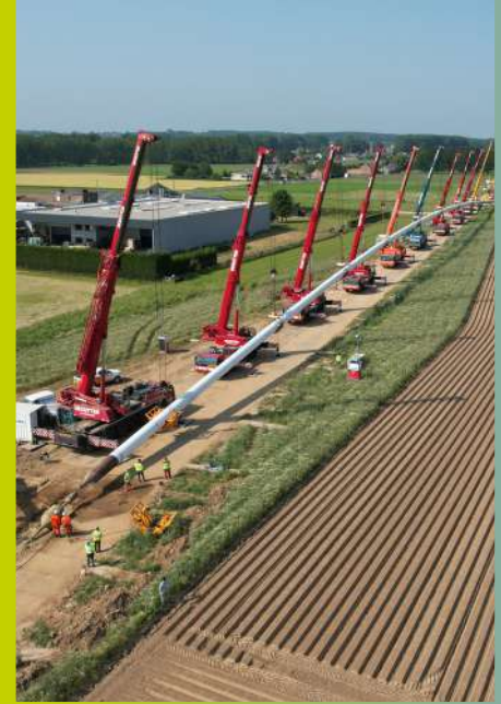
44 km hydrogen-ready gaspijpleiding Opwijk-Desteldonk
