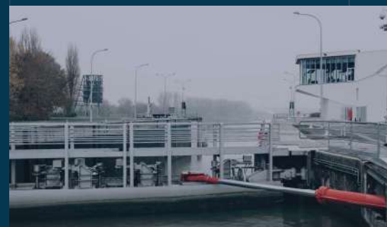
Renovatie sluisdeuren (Zemst)
